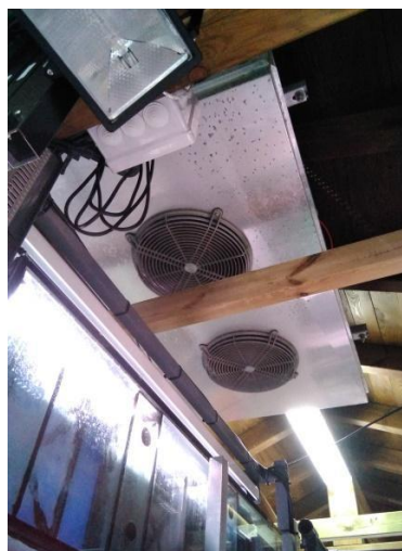
Figura 15: Sistema de refrigeració.
