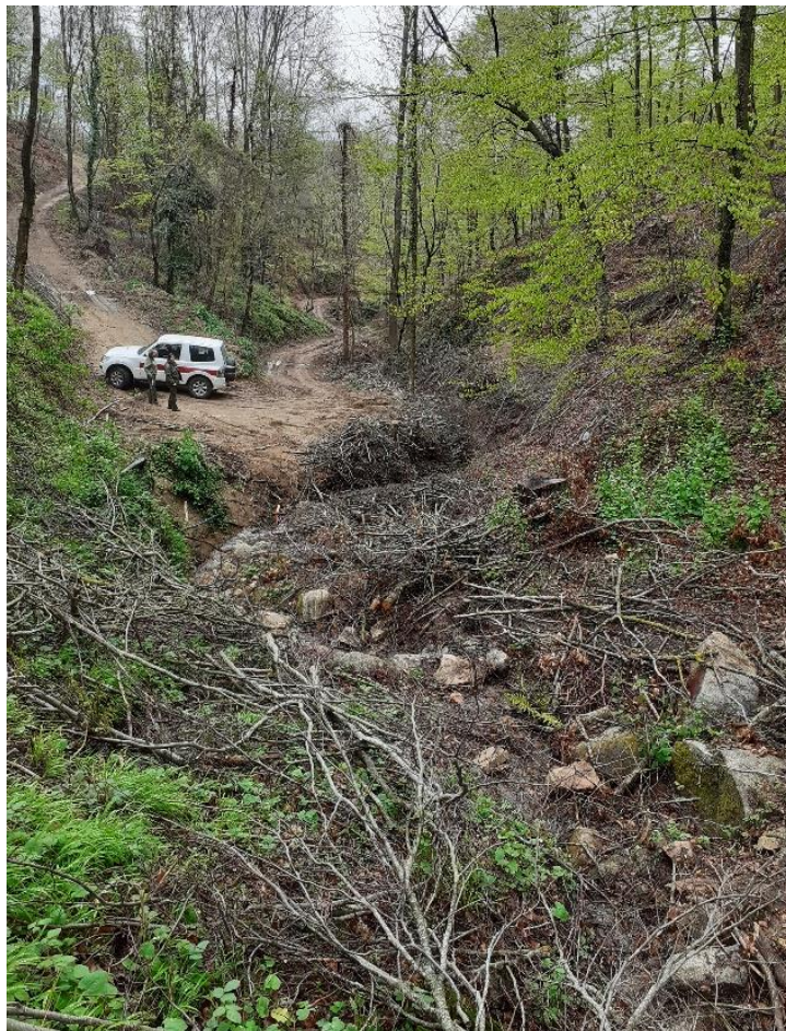
Torrent totalment alterat per la construcció d'una pista forestal de desemrocament (foto: D. Guinart).
