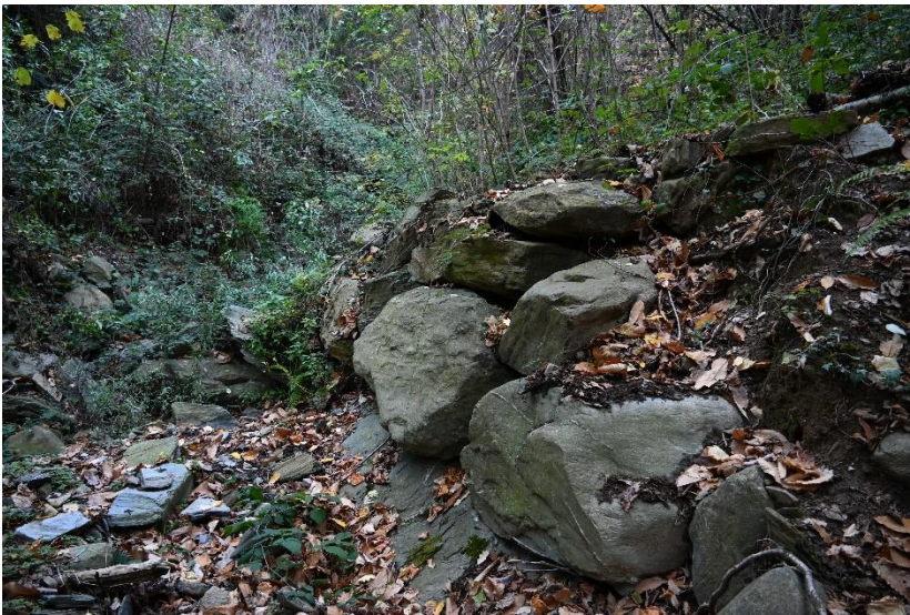
Figura 27. Detalle de uno de los bancales construido con rocas extraídas del mismo cauce.
