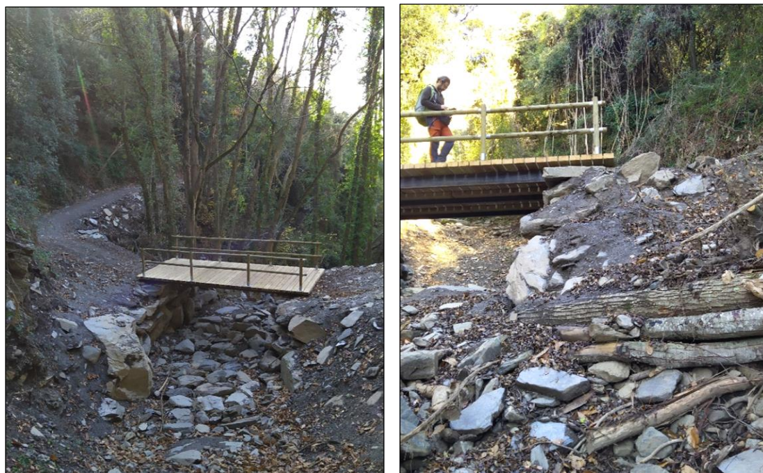
Figura 13. Imágenes del otoño de 2020. Vistas del puente y de la restauración de los cauces desde la parte superior del torrente y vistas en primer plano de los fascines en uno de los cauces aguas abajo pasado el puente.
