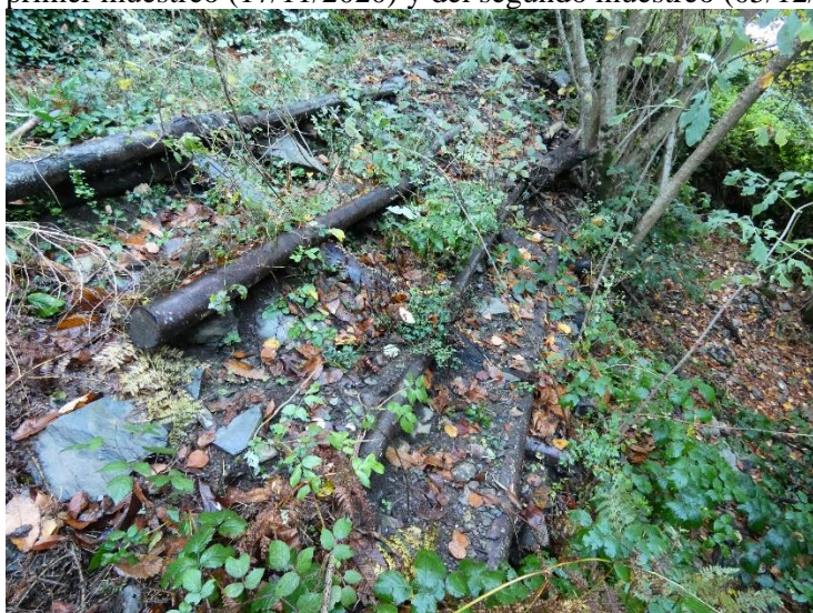
Figura 23. Detalle de una de las fajinas donde ha comenzado el proceso natural de recubrimiento por la vegetación natural.
