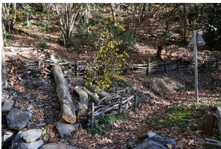
Figura 21. Detalle de los fajas hecha con ramas y troncos en una de las orillas del cauce restaurado.
