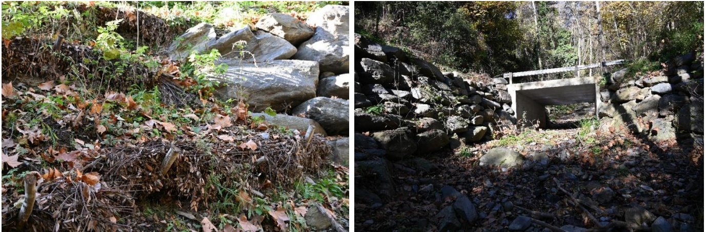
Figura 22. Izquierda. Detalle de una de las fajinas por debajo del puente con plántulas. Derecha. Vista general de la actuación de restauración del cauce desde la parte de debajo del puente.
