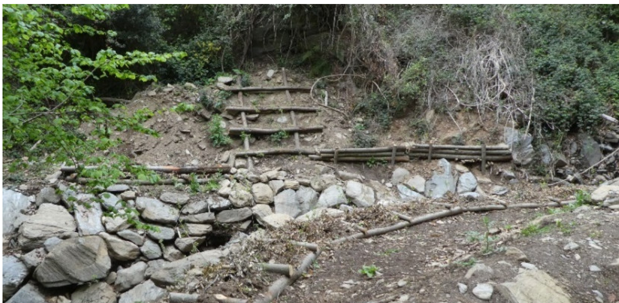
Consolidació del marge del torrent amb diverses tècniques d'enreixat i palissada
