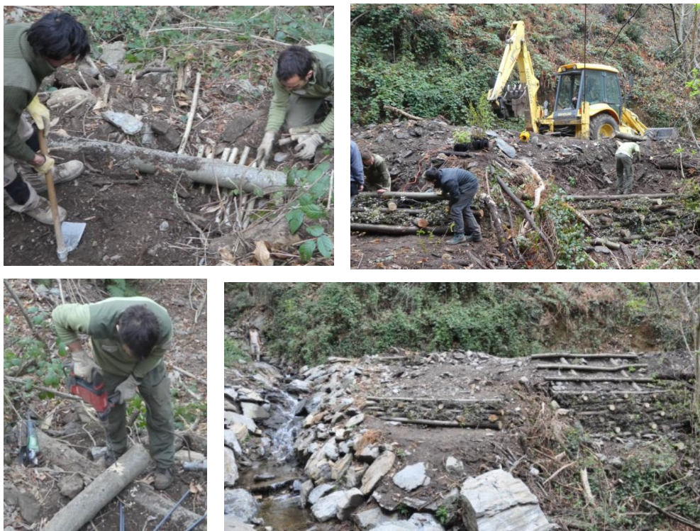
Procés de construcció d'entramat Krainer amb plantació de planta
