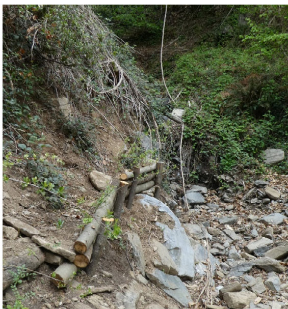
Procés de construcció d'una palissada i diferents exemples
