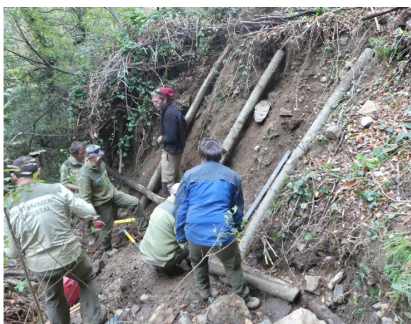
Procés de construcció d'enreixat sobre talús
