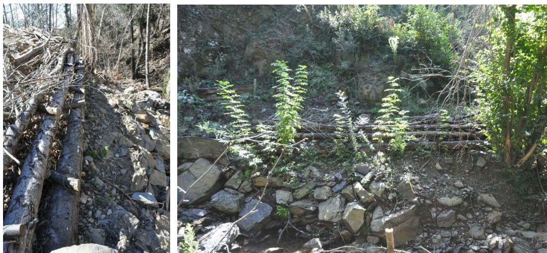
Entramat Krainer sense terra ni plantació, recent fet i un any després
