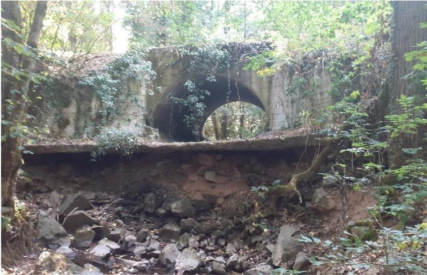
*Puente con el cauce del torrente hormigonado, con la consecuente erosión aguas abajo*
