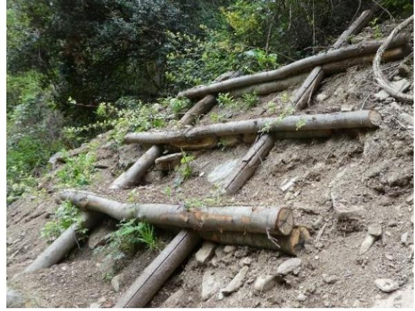
*Proceso de construcción de enrejado sobre talud*
