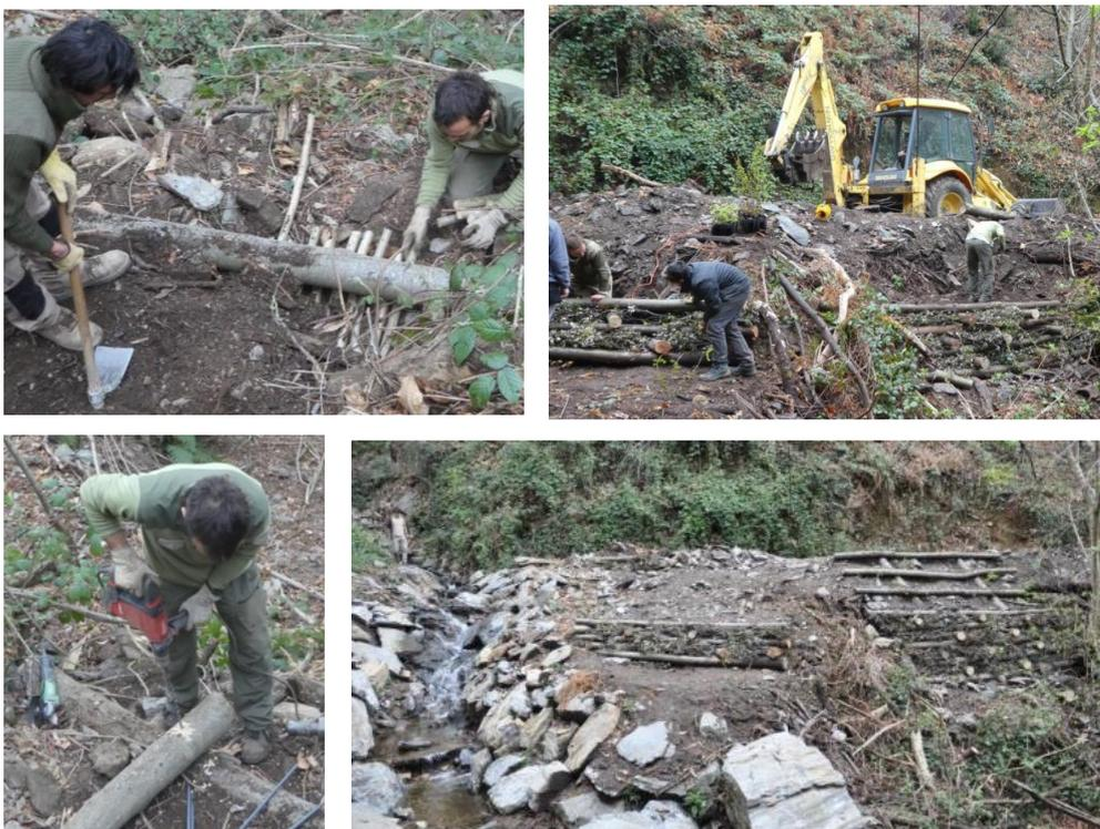
*Proceso de construcción de entramado Krainer con plantación de planta*
