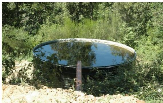
Deposito metálico de recogida de pluviales
