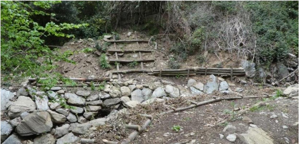
*Consolidación del margen del torrente con diversas técnicas de enrejado y empalizada*
