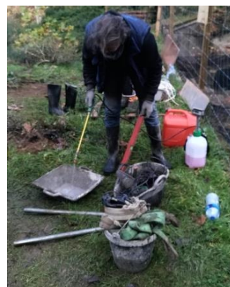
Desinfecció del material utilitzat a l'obra
